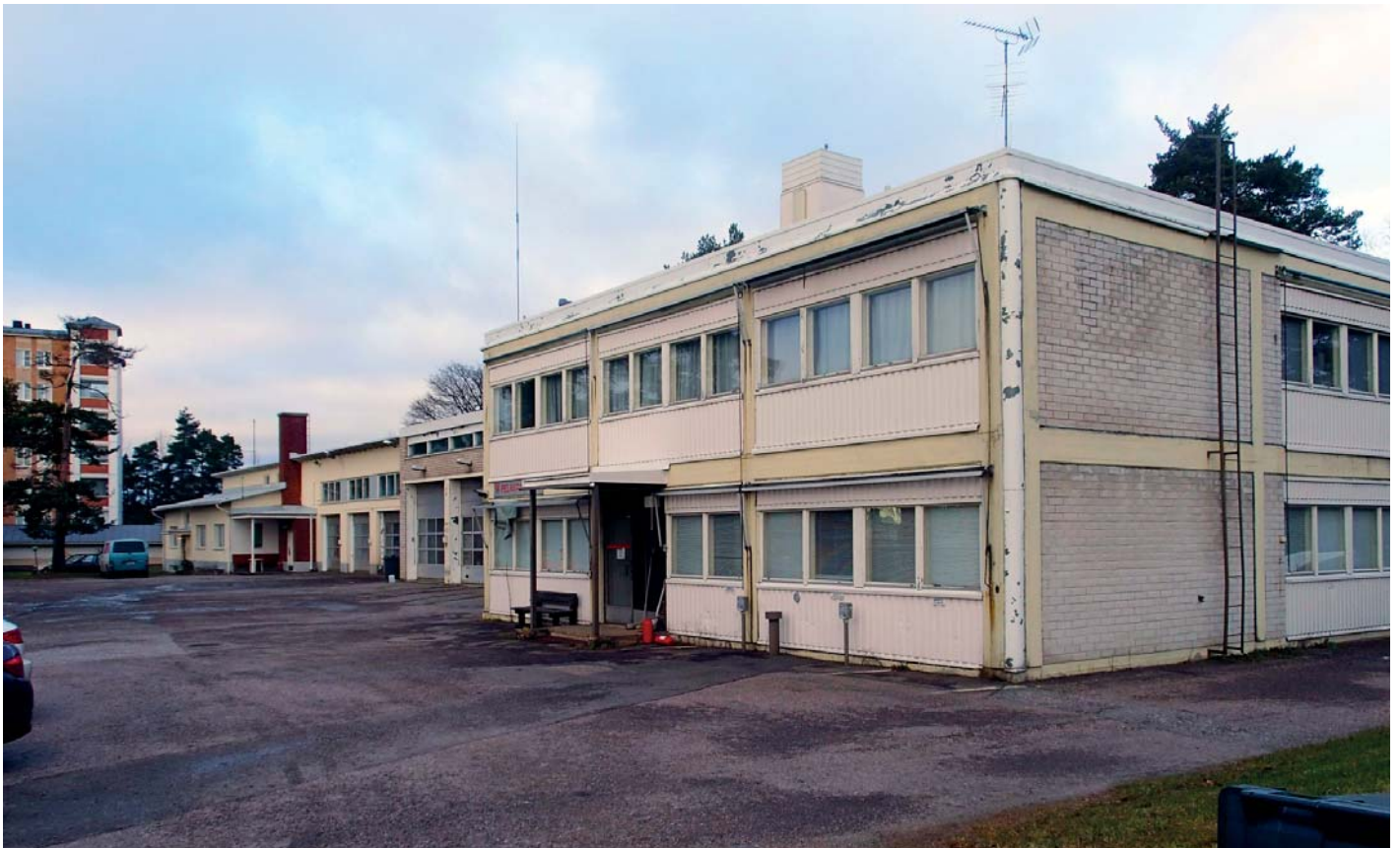
Vanha paloasemarakennus. Rakennus puretaan asuinkerrostalorakentamisen alta.
